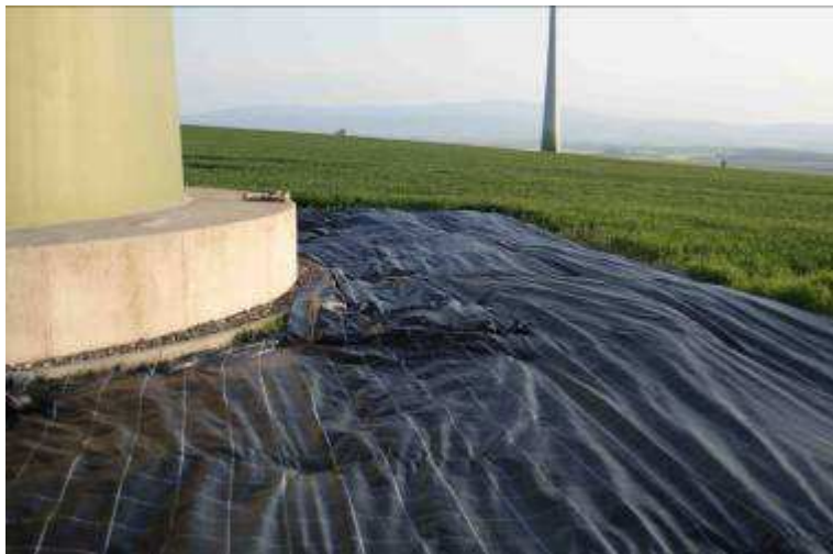
Abb. 3-17: Mit Folie abgedeckte Mastfußbrache.
