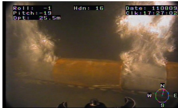
Abb. 1-15: Düsenschlauch auf dem Meeresgrund, Blasenschleier in Betrieb.
