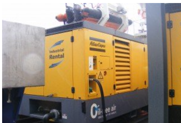
Abb. 1-12: Eingesetzter Kompressor zur Generierung der notwendigen Luftmenge für den Blasenschleier.
