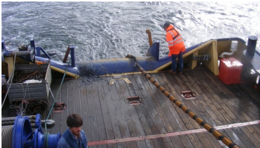
Abb. 1-10: Das Deck bietet noch ausreichend Platz, um kleinere Reparaturen durchführen zu können. Beim Verlegen des Blasenschleiers läuft der Düsen Schlauch kontrolliert über das Heck in die See.
