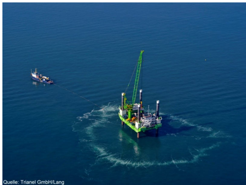
Abb. 1-8: Der Große Blasenschleier in Betrieb bei Rammarbeiten im Windpark Borkum West II.
