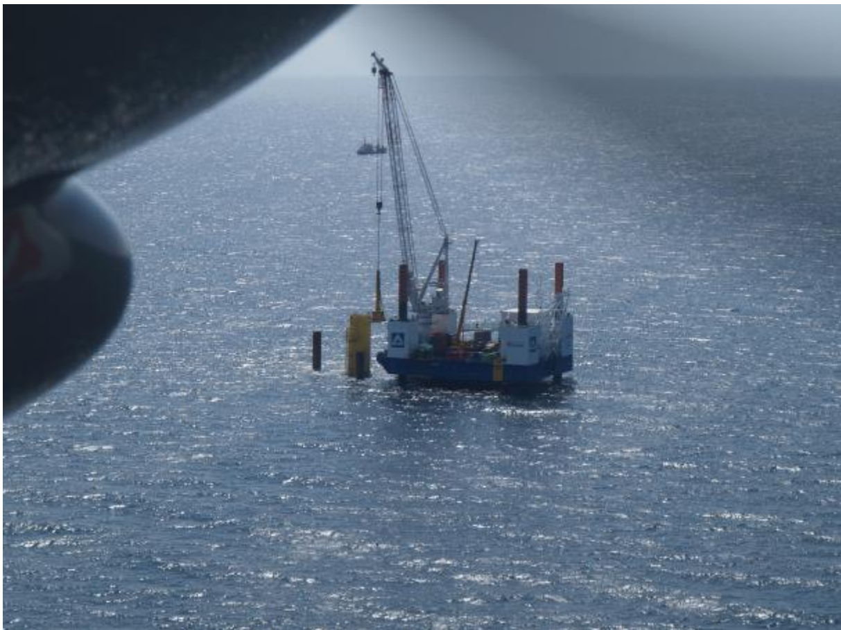
Abb. 13: Baufeld „alpha ventus“ nach der Befliegung zur Effizienzkontrolle der Vergrämungsmaßnahmen am 18.05.2009 vor Beginn der Rammarbeiten (Foto: M. Laczny)
