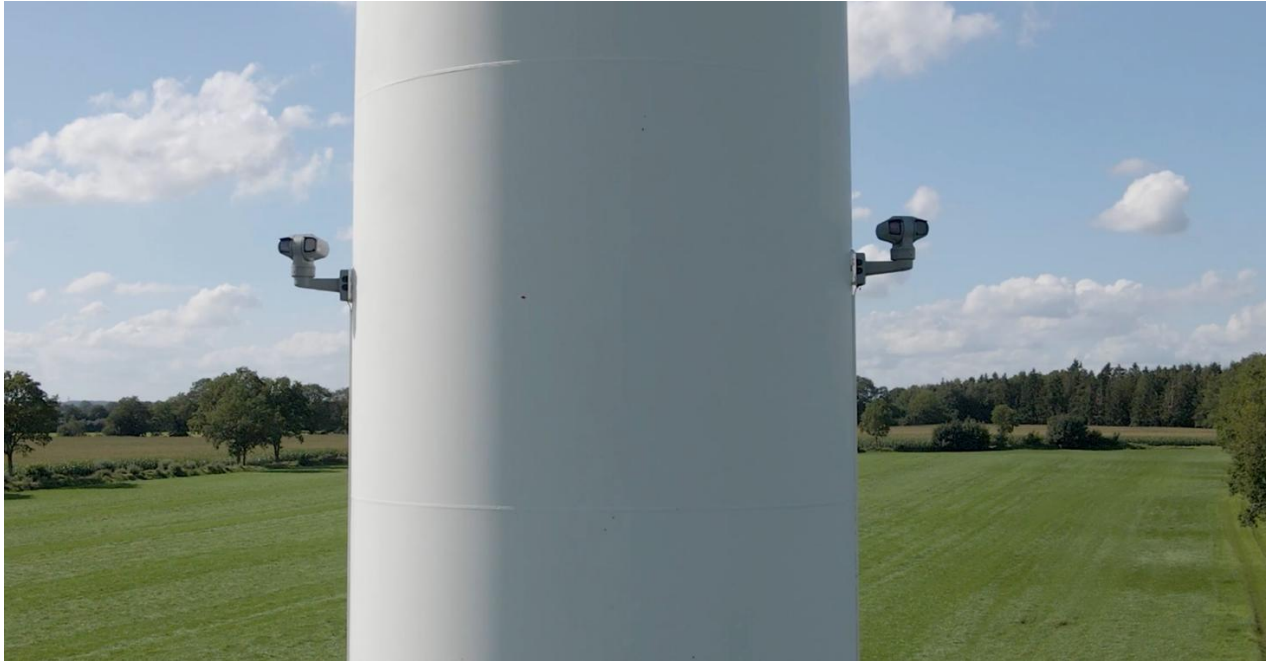
Abbildung 6: Installierte zwei AVES Wind Onshore AKS an einer Nordex N149 Testanlage im WP Timmaspe (Foto: ProTecBird 2024).
