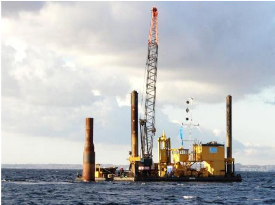
Bild 4.3. Stelzenponton JB6189. Links der Testpfahl mit aufgesetztem Follower
