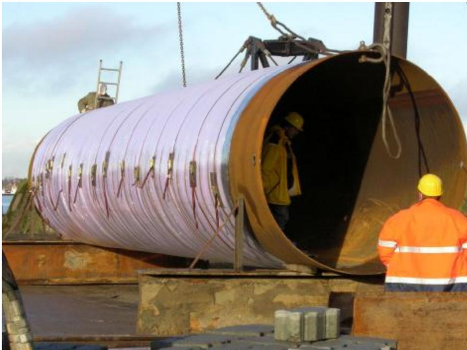
Bild 4.7. Das mit PE-Schaumfolie beschichtete Rohr
