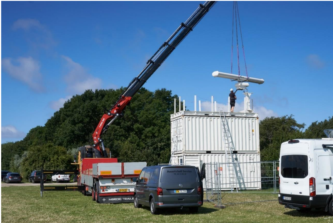
Abbildung 16: Aufbau des Radarsystems 5
