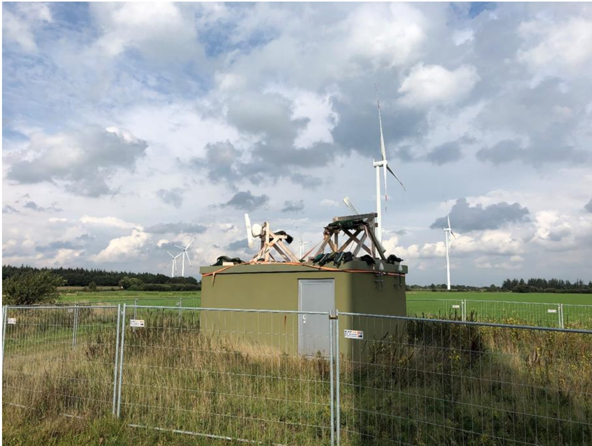
Abbildung 58: Versuchsaufbau Enge-Sande: Die Antennen der beiden Radargeräte wurden vertikal drehend auf dem Dach der Servergarage der Windparks installiert. Die Antenne links im Bild ist auf die bedarfsgerecht nachtbefeuerten Anlagen des Windparks Holzacker-Knorborg (einige WEA sind im Hintergrund erkennbar) gerichtet, die Antenne rechts überwacht den Bereich des nachts durchgehend befeuerten Windparks Hollmark (WEA nicht abgebildet).
